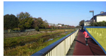
トンネル位置↑
